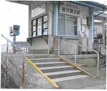
車椅子利用が可能となるスロープ設置が決まった岩代清水駅
