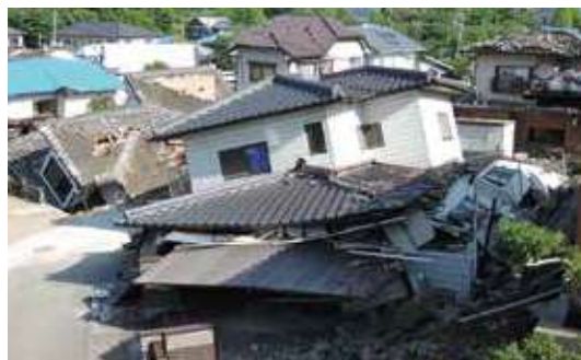
地震による被害例（熊本地震）
