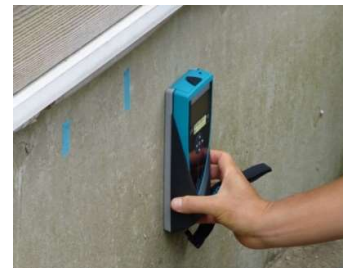
基礎配筋の調査
