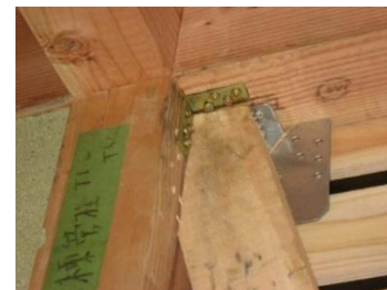
接合部 ※天井裏等から撮影
