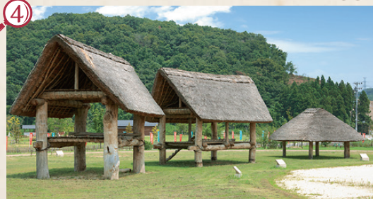
掘立柱建物 機械の無かった時代に、直径90cm、1本約3トンの大きな柱を使用した建物はなぜ、どのように建てられたのか？
