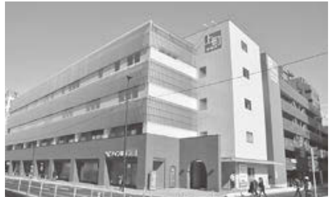
▲上町テラスビル外観
