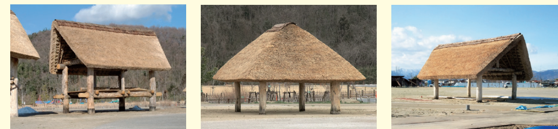
2号掘立柱建物 ①-b 高さ:7.03m 柱直径:60cm 5号掘立柱建物 ①-c 高さ:4.69m 柱直径:32~35cm 10号掘立柱建物 ①-d 高さ:4.42m 柱直径:31~36cm
