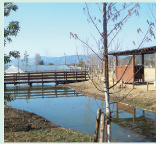
湿地と中央部の橋
