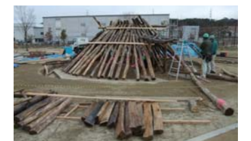
③屋根支えの垂木をかけます
