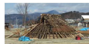
④土屋根を支えるため、下地の樹皮を敷きます
