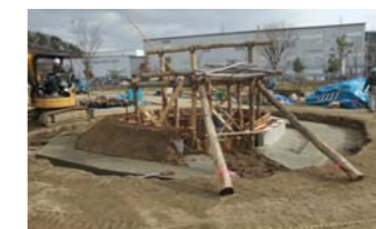
②主柱を建てます
