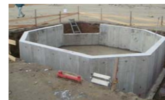
①湿気防止のためコンクリートの基礎を敷いています
