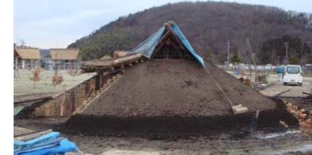
⑤、⑥土をのせ、土屋根を仕上げて完成です
