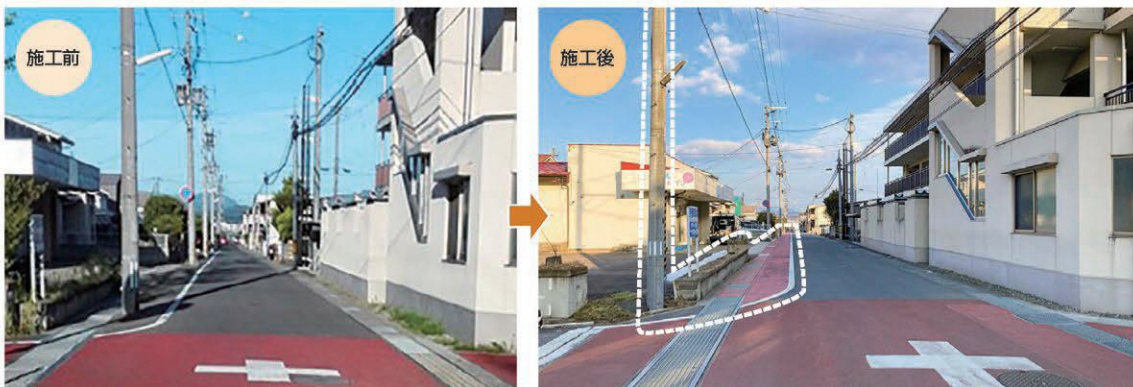
電柱の移設、カラー舗装化
