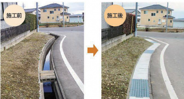
道路側溝修繕工事(吾妻地区)
