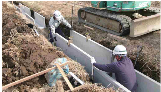
水路への側溝敷設の様子
