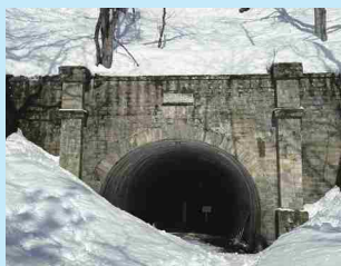
■二ツ小屋隧道
