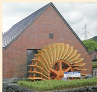
▲四季の里小水力発電設備
