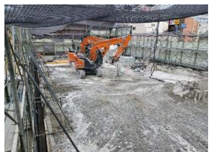
⑧ D街区 福島栄町ビル 階上解体状況
