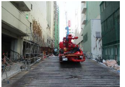
④ 覆工構台設置状況
