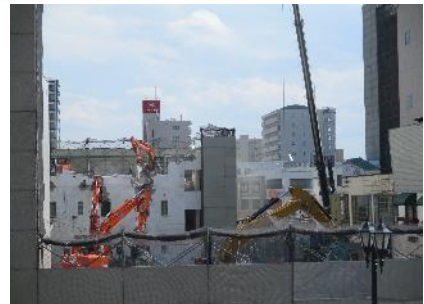
⑦ D街区 低層棟 解体状況
