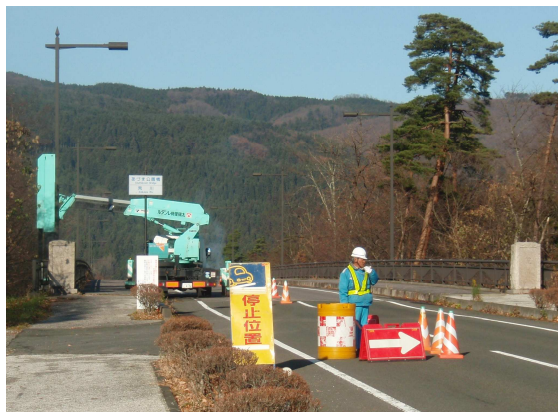
詳細点検の例（橋梁点検車使用）
