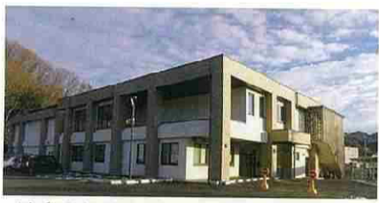
駐車場整備も完了した渡利学習センター
