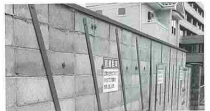
危険なブロック塀の撤去事業を推進
