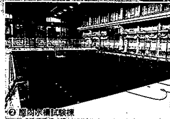
② 屋内水質試験場
