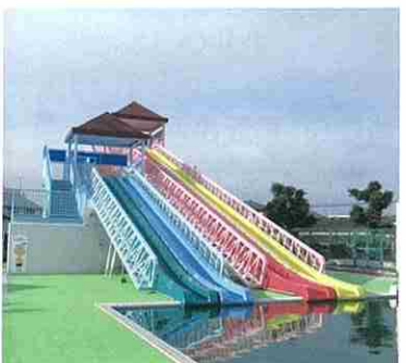
リニューアルされた中央市民プール
