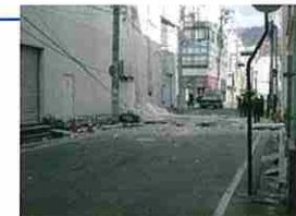
平和ビルの壁が崩落
