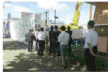
北広島駅西口の工事現場視察
