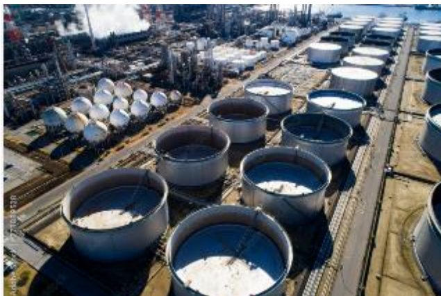
参考写真：浮き屋根式特定屋外タンク貯蔵所の外観
