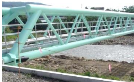
摺上川水管橋架替工事
