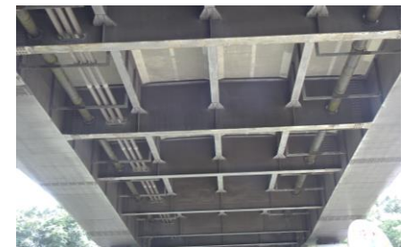
飯坂大橋添架管塗装替修繕工事
