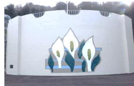
金剛山配水池防水塗装替修繕工事
