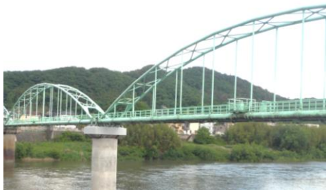
阿武隈川水管橋耐震補強工事
