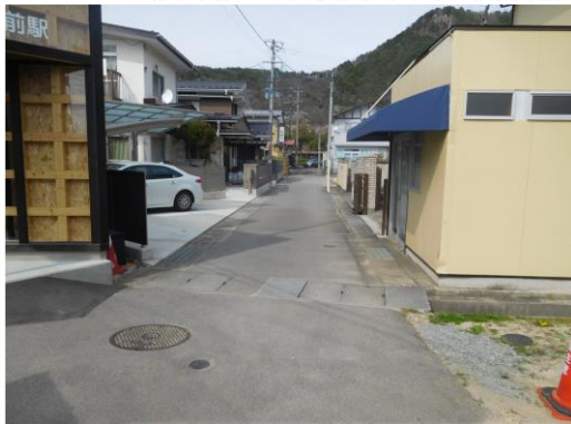
台3号線 L=40m (ストリートプリント舗装)
