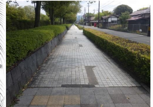
西養山・戸ノ内線 L=300m (平板ブロック、点字ブロック設置)
