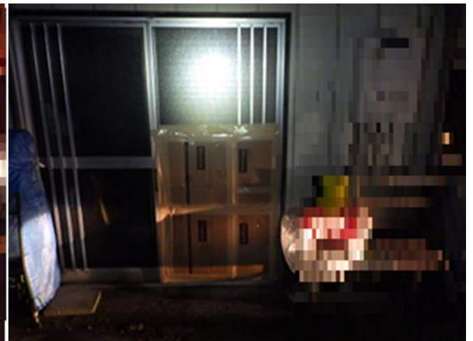
応急処置状況
