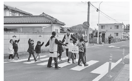
区画線とポール設置をした交差点
