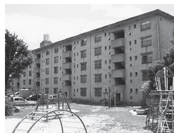
蓬萊市営住宅
