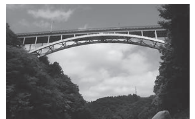
平成20～21年度に耐震補強工事を終えた上蓬菜橋の様子
