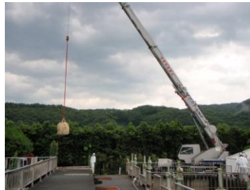
反応槽(遊休施設)への 移設状況
