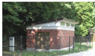
◆ 祓川浄化施設
