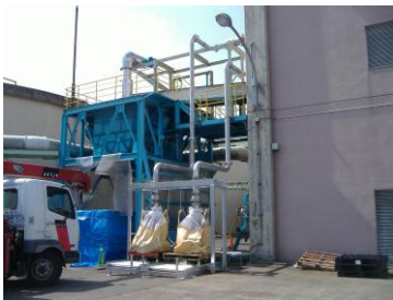
脱水汚泥を 大型土のう袋に詰める
