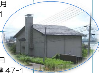
渡利雨水ポンプ場
