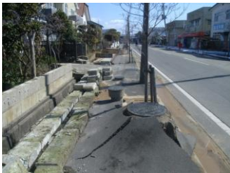
◆マンホール浮上
