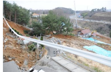
◆法面崩壊に伴う下水管被災
