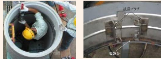
マンホールの耐震化工法イメージ 出典：『スナップロックカタログ』 日本スナップロック協会
