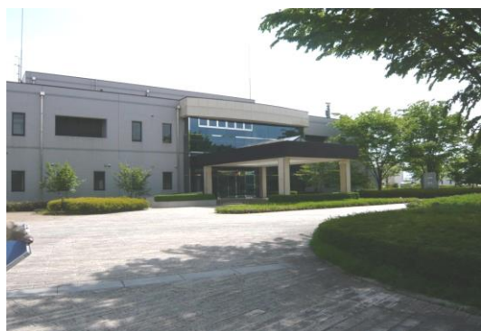
県北浄化センター管理棟
