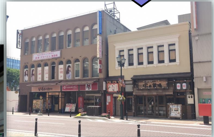
修景整備施工後
