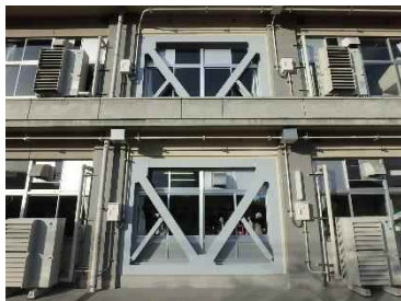
耐震補強 事例
