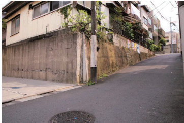
擁壁や坂に面する
