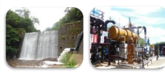
砂防堰堤を利用した小水力発電 既存温泉を利用したバイナリー発電
