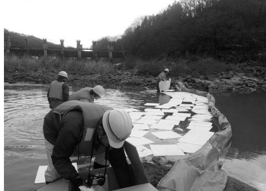
水質事故対応（オイルフェンス設置）
