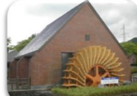
地域資源を活用した小水力発電
