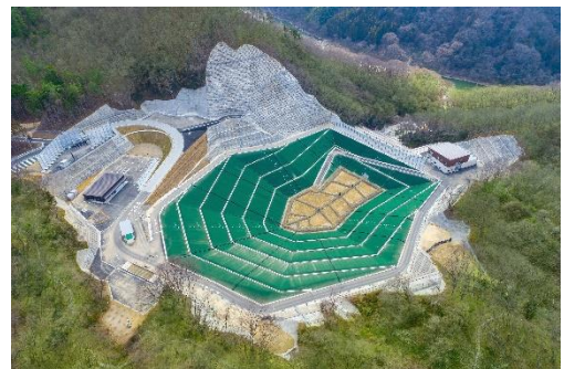
大館山一般廃棄物最終処分場全景
