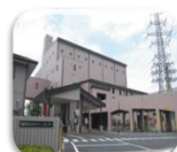
ごみ焼却時の余熱で発電した 電力の地産地消事業
