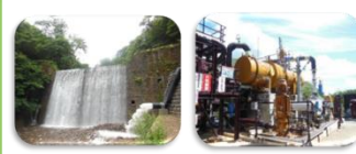
砂防堰堤を利用した小水力発電 既存温泉を利用したバイナリー発電
