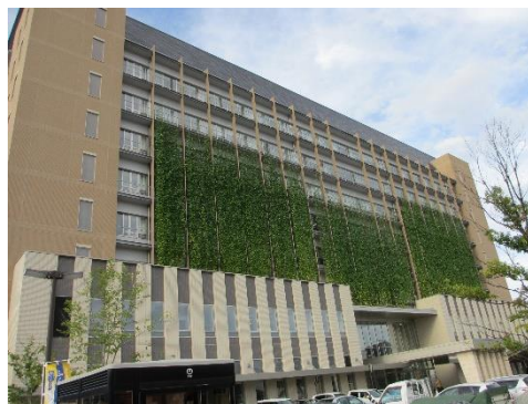
グリーンカーテン（市役所本庁舎）
