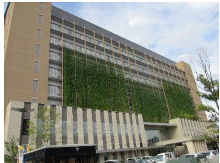
グリーンカーテン（市役所本庁舎）
