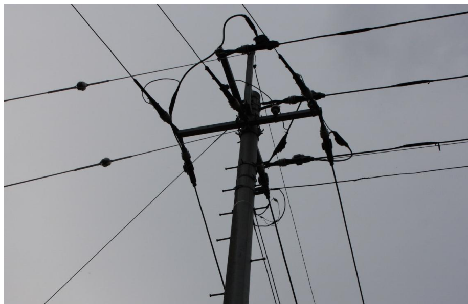
【写真一6】 接続電柱
