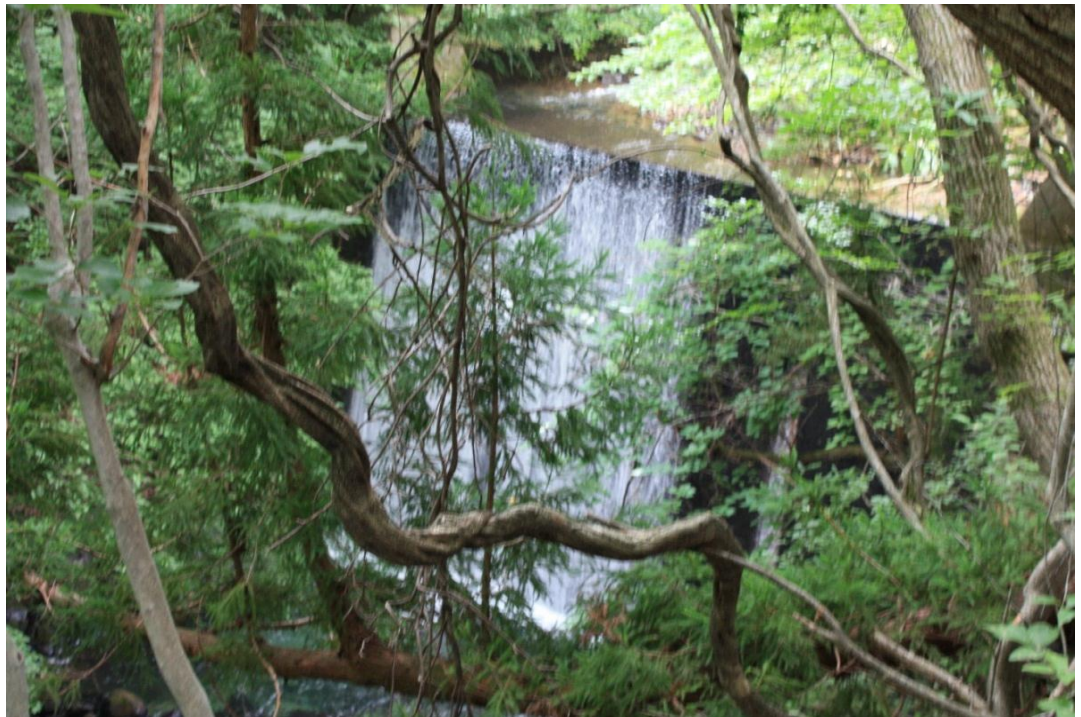
【写真-1】水沢堰堤の全景
