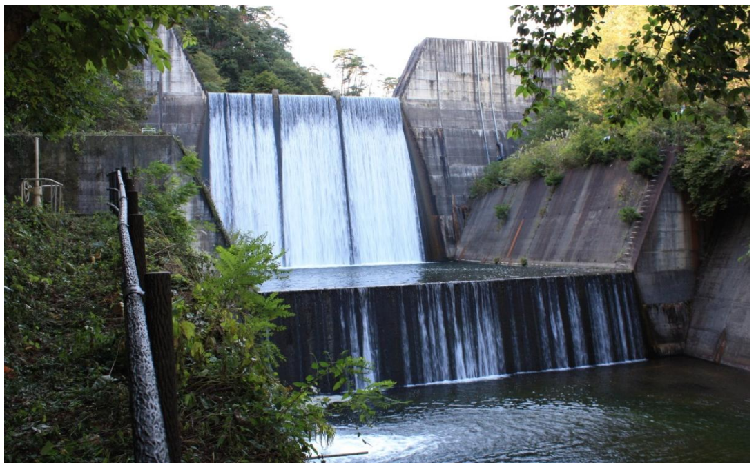
【写真-1】小川砂防ダム(全景)
