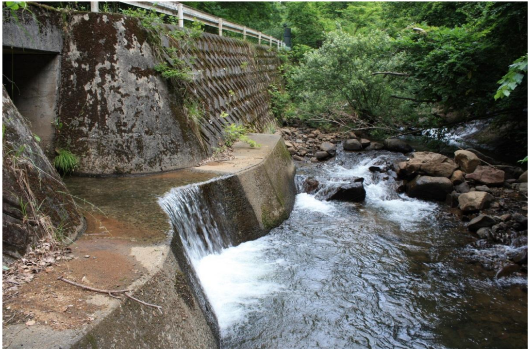
【写真-1】上流の地蔵川との合流地点。(下流から上流を撮る)
