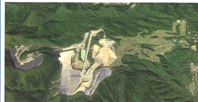
(6)仙台ハイランドPJ (52.9MW/DC)
