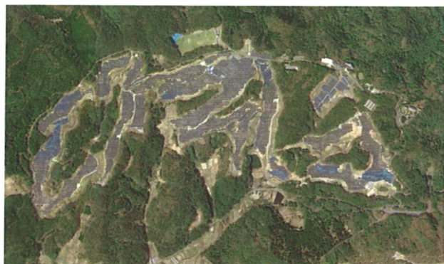
(1)諏訪ゴルフPJ (46.7MW/DC)
