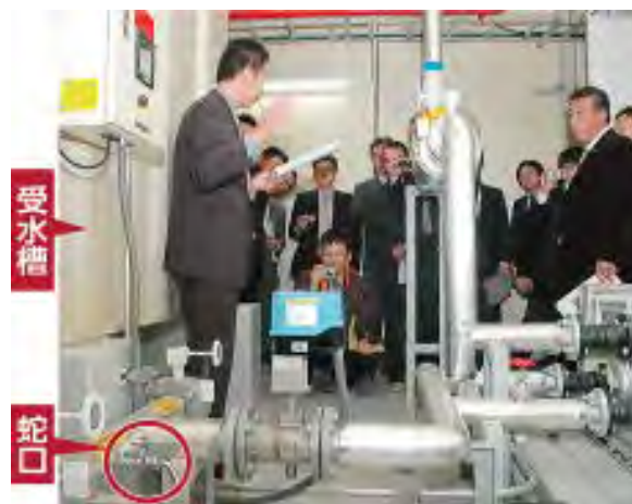
写真-6.10.1.9 受水槽に取り付けられた蛇口（新潟県長岡市立宮内小学校）
