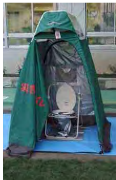
写真-6.10.1.8 マンホールトイレ設置の様子（東京都目黒区）
