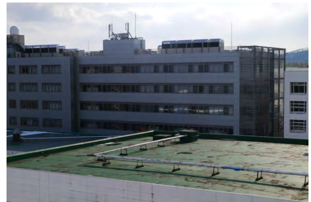
写真-8.1.1.10 M 講義棟の屋上 (2)
