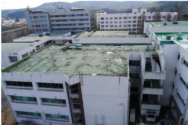
写真-8.1.1.7 S 講義棟の屋上 (1)
