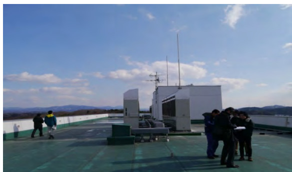
写真-8.1.1.3 経済経営学類棟の屋上 (1)
