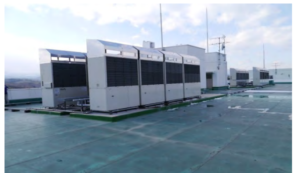
写真-8.1.1.4 経済経営学類棟の屋上 (2)
