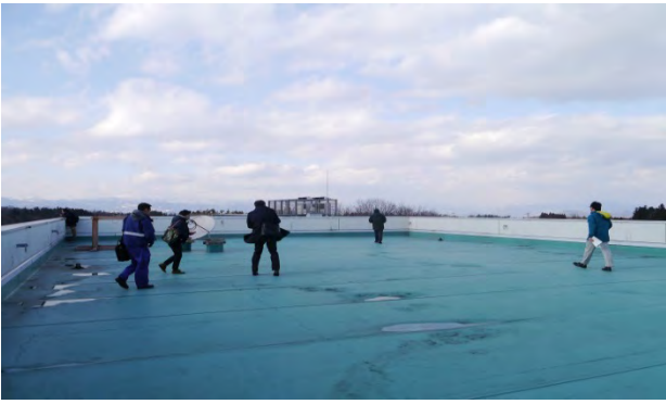
写真-8.1.1.5 行政政策学類棟の屋上 (1)
