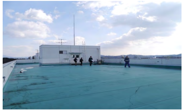
写真-8.1.1.6 行政政策学類棟の屋上 (2)
