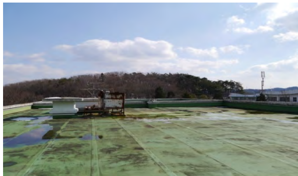
写真-8.1.1.1 事務棟の屋上 (1)
