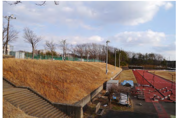
写真-8.1.1.14 陸上競技場 東側法面
