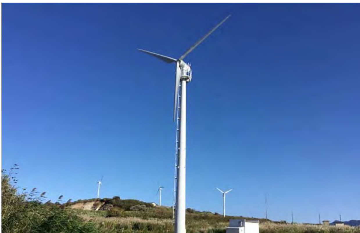
写真-8.2.1 20kW未満の小型風力発電(一般財団法人ふくしま未来研究会 ホームページより)
