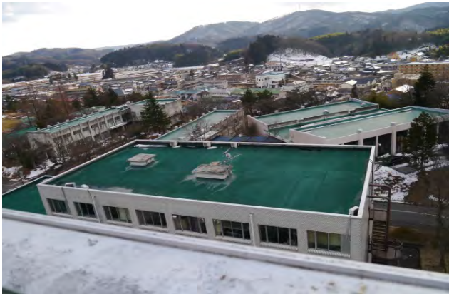
写真-8.1.1.13 教育研究センターの屋上
