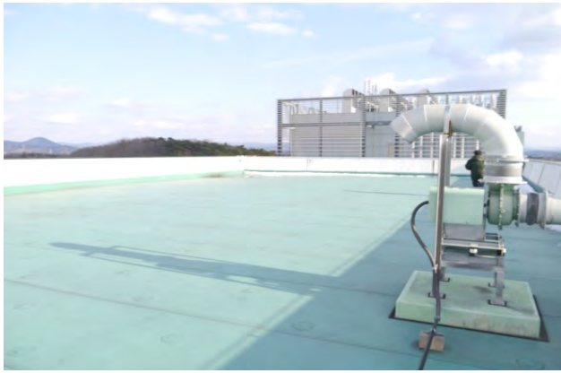
写真-8.1.1.11 人間発達文化学類棟の屋上(1)
