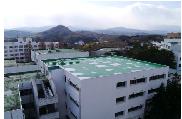
写真-8.1.1.8 S 講義棟の屋上 (2)
