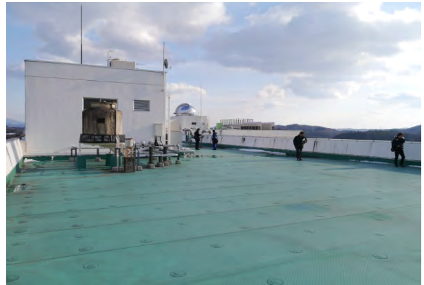
写真-8.1.1.12 人間発達文化学類棟の屋上(2)
