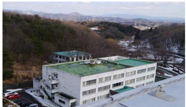
写真-8.1.1.2 事務棟の屋上 (2)
