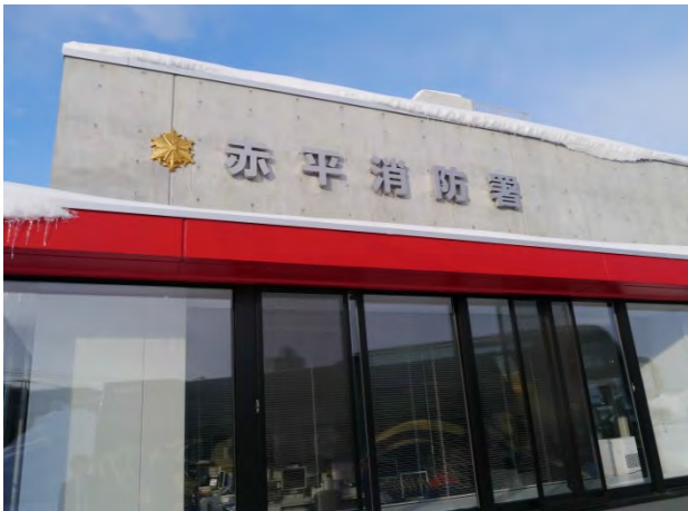
写真-1.6.1 施設外観
