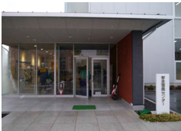
写真-1.2.5.1 安全啓発センターの外観
