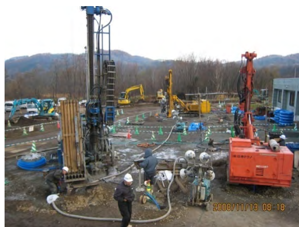
写真-2.3.5 工事風景
