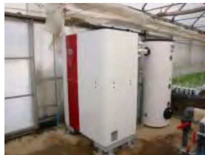
写真-2.6.3 水冷式ヒートポンプ
