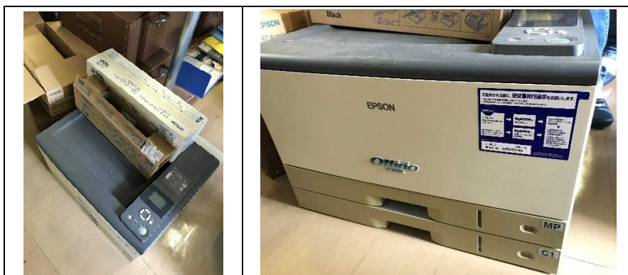
堀河町終末処理場管理棟 2 階旧操作室 プリンター
