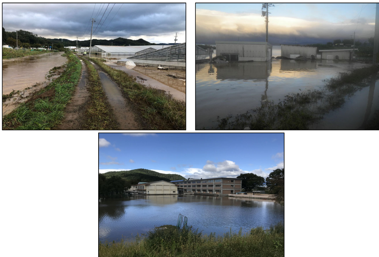
図 3-13 内水による浸水発生状況
