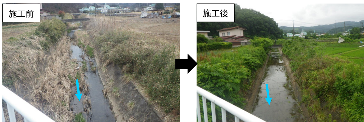
図 4-49 土砂浚渫の状況(胡桃川)
