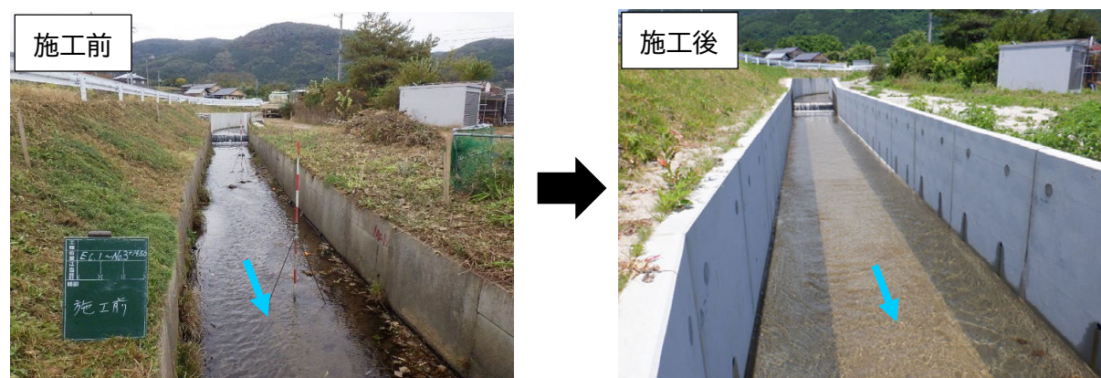
図 4-52 河川改修の状況(大堀川)
