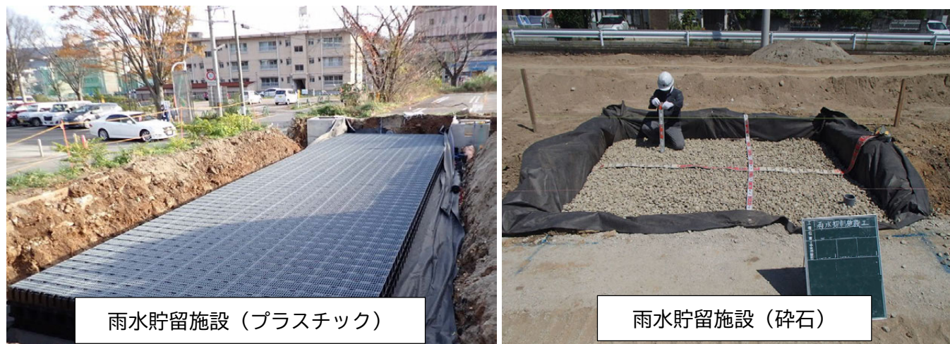
図 4-57 民間雨水貯留施設設置のようす
