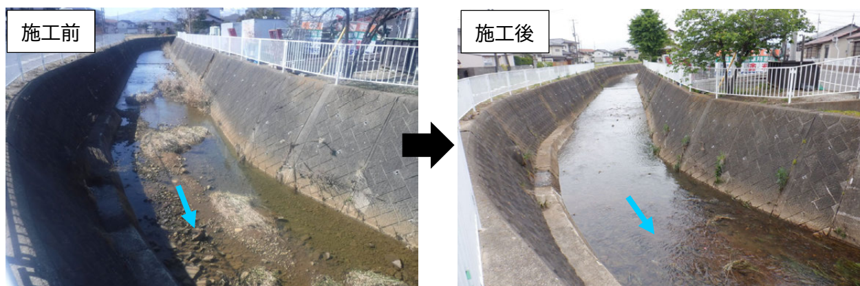
図 4-47 土砂浚渫の状況(耳取川)
