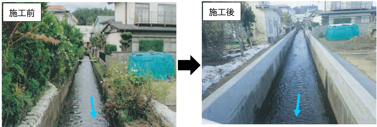
図 4-44 雨水渠(開渠)整備の状況
