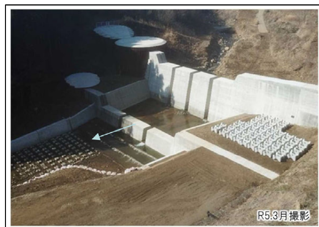
図 4-17 土砂対策の状況(東八川)
