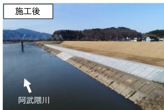
図 4-5 護岸復旧の状況
