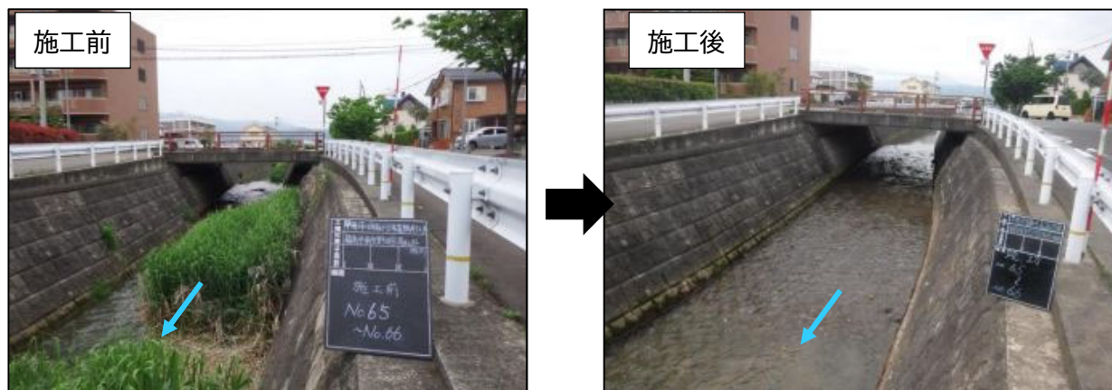
図 6-7 河川浚渫の状況(耳取川)
