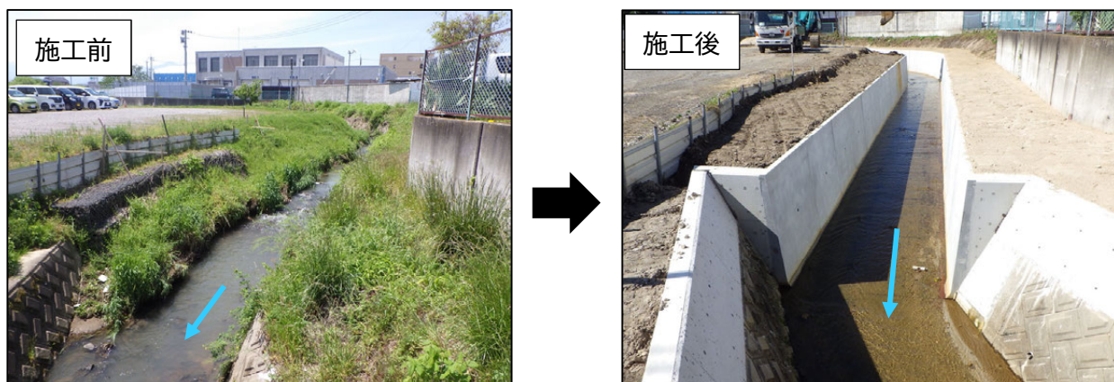
図 6-6 護岸整備の状況(渋川)
