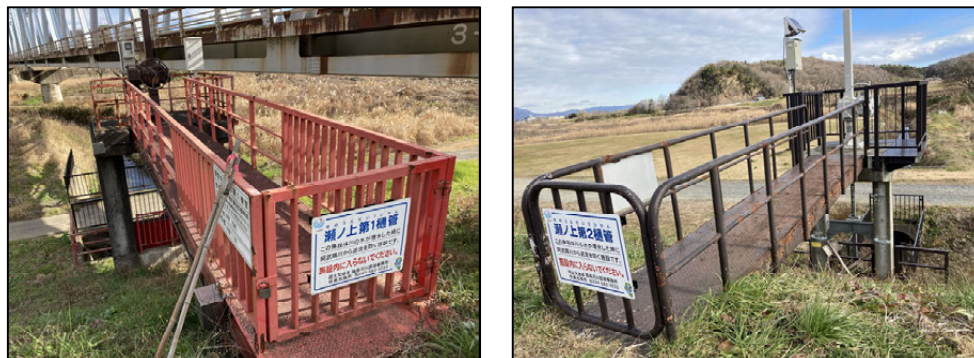
図 6-8 市内に設置している樋管
