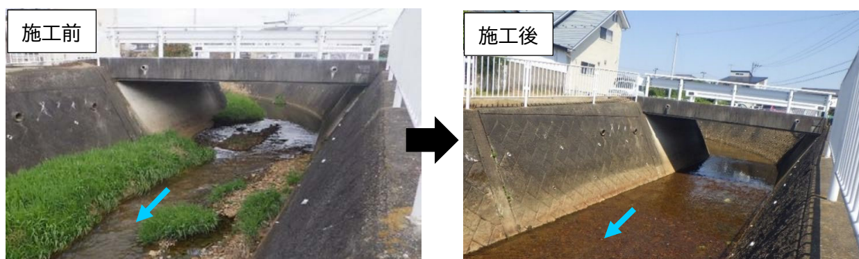
図 4-48 土砂浚渫の状況(馬川)
