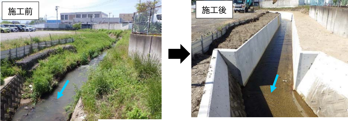
図 4-50 河川改修の状況(渋川)
