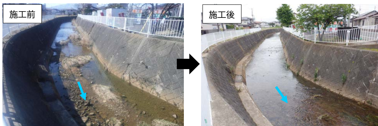
図 4-47 土砂浚渫の状況(耳取川)
