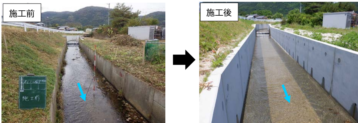
図 4-52 河川改修の状況(大堀川)
