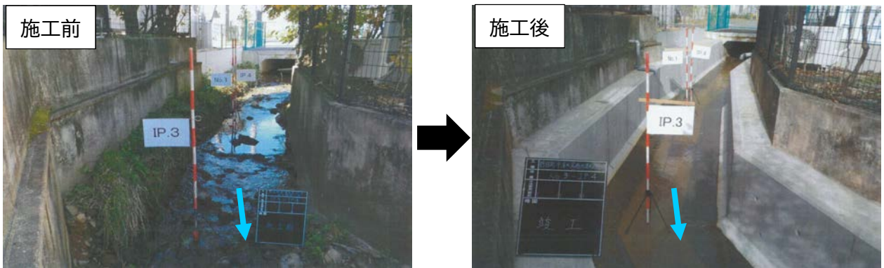
図 4-45 雨水渠(開渠)整備の状況
