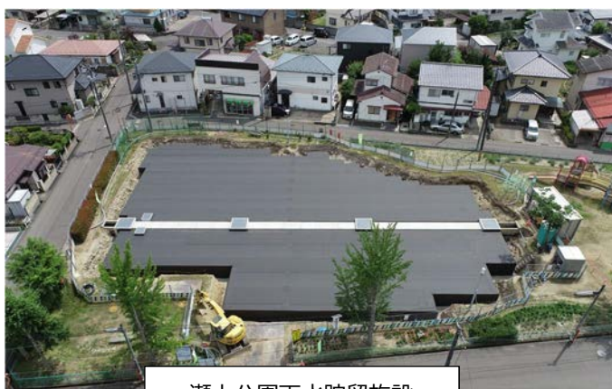
瀬上公園雨水貯留施設
