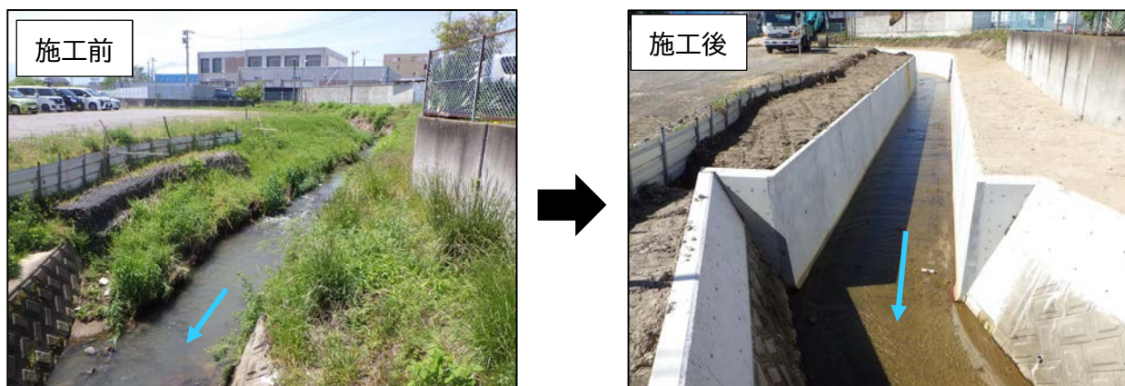
図 6-6 護岸整備の状況(渋川)
