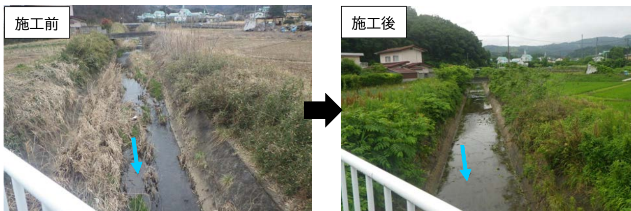
図 4-49 土砂浚渫の状況(胡桃川)
