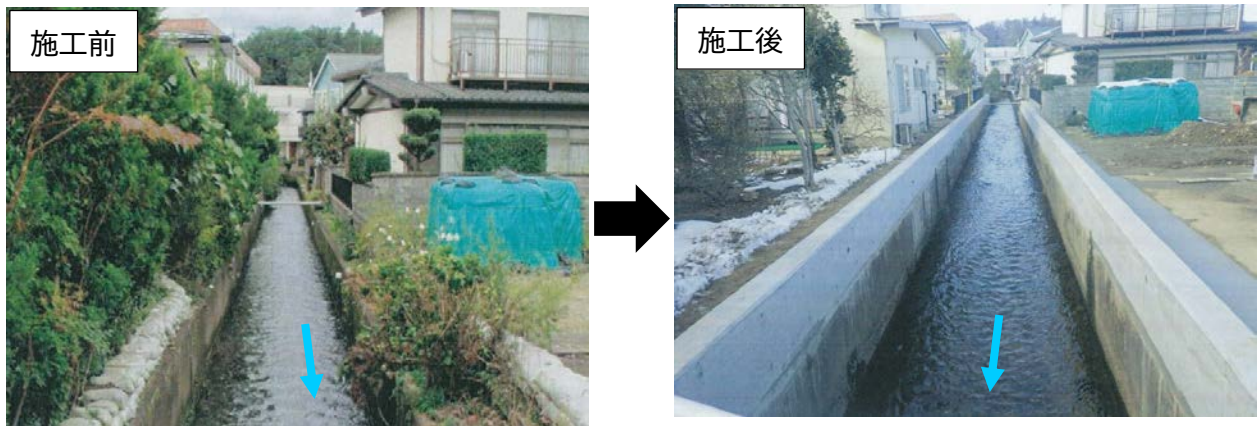
図 4-44 雨水渠(開渠)整備の状況
