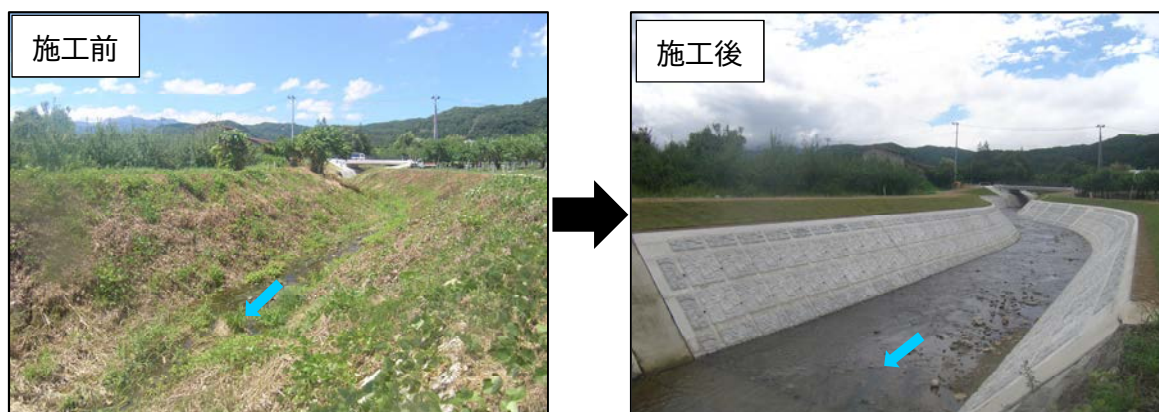
図 4-14 護岸整備の状況(八反田川)
