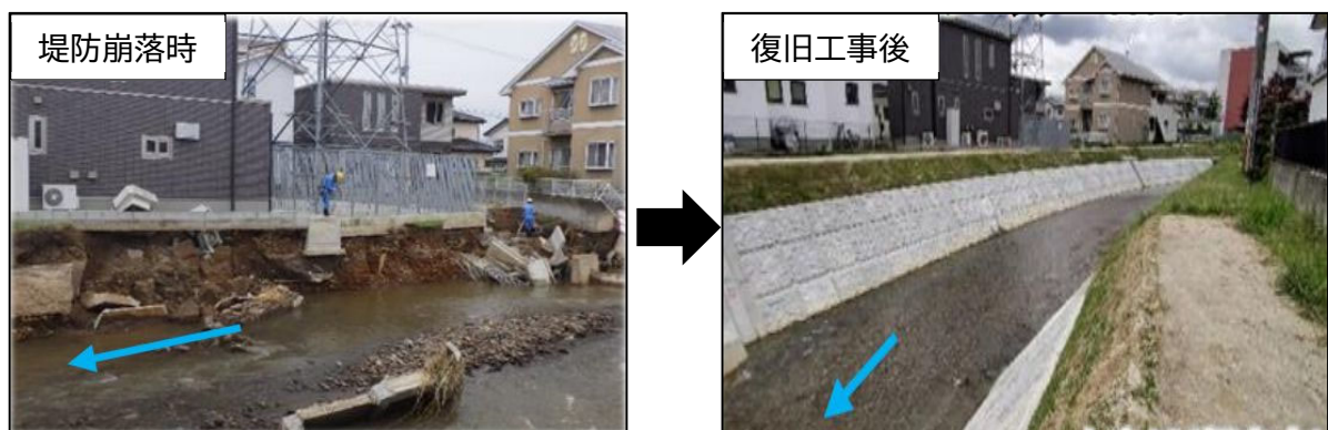
図 4-12 堤防復旧の状況
