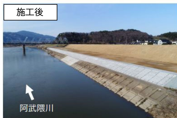
図 4-5 護岸復旧の状況
