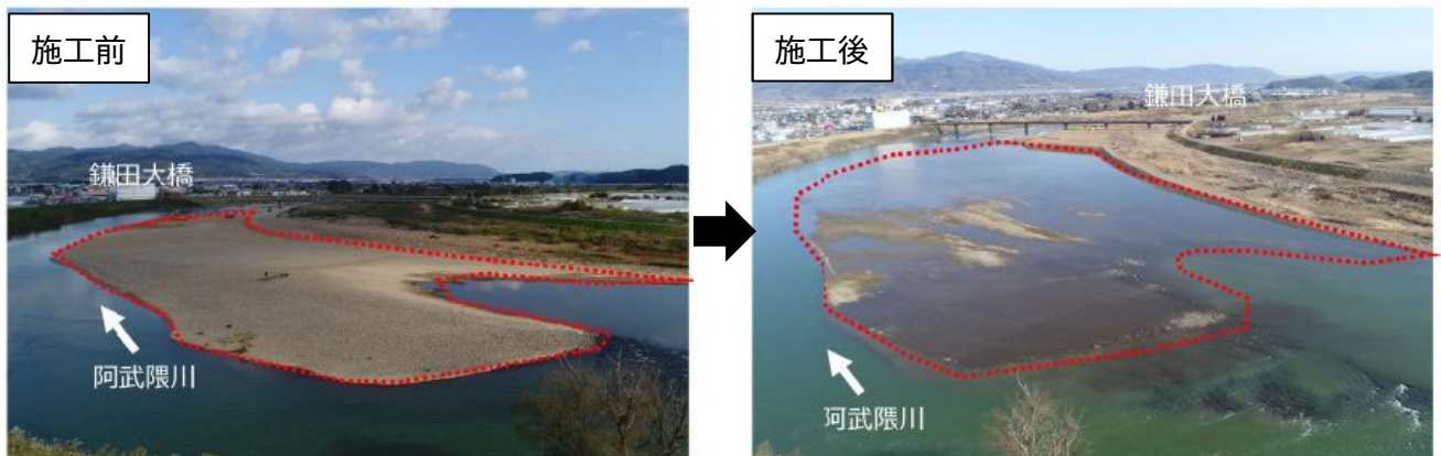
図 4-2 河道掘削の状況
