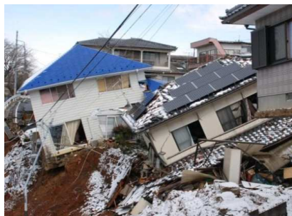
土砂崩れ・家屋倒壊
